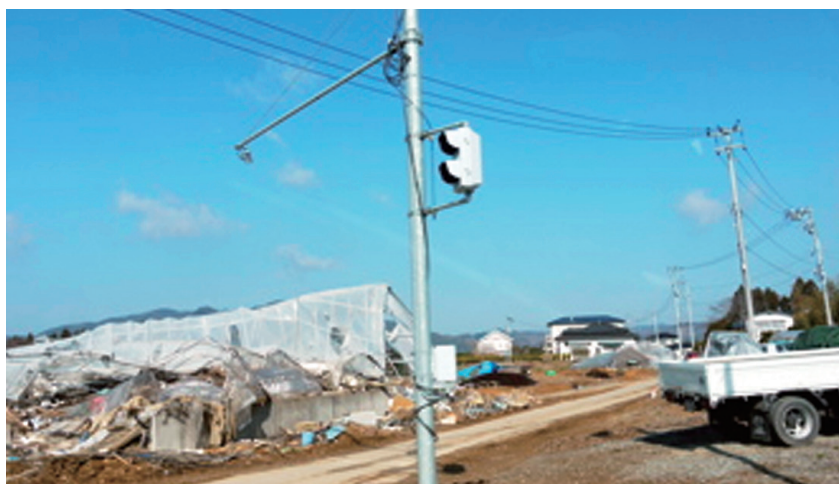
図2 津波による停電で信号も機能していない
